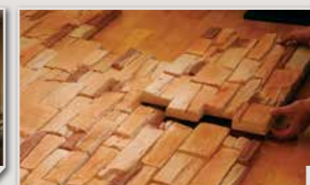
2. Před zahájením montáže vyskládáme požadovaný vzor. Jako první se zakládá spodní řada.
