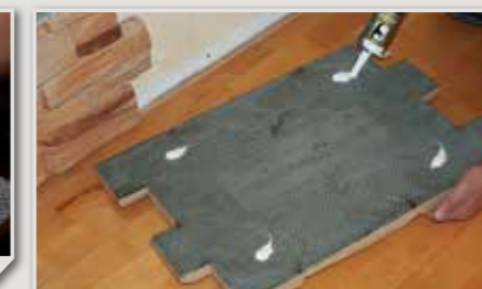
4. Na rubovou stranu panelu nanese bodově montážní lepidlo
