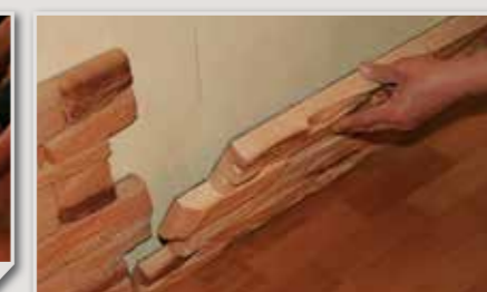
2. Před zahájením montáže vyskládáme požadovaný vzor. Jako první se zakládá spodní řada.
