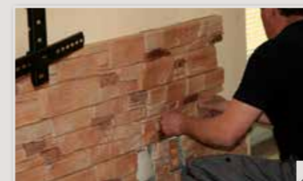
5. Obkladový panel pevně přitlačíme k montážní ploše
